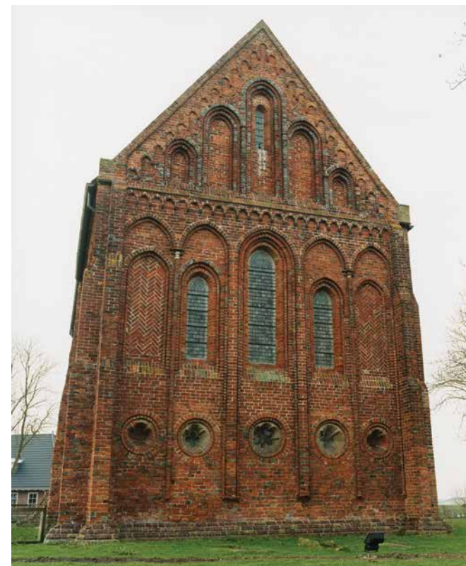
▲ Het metselwerk van de kerk van Termunten
